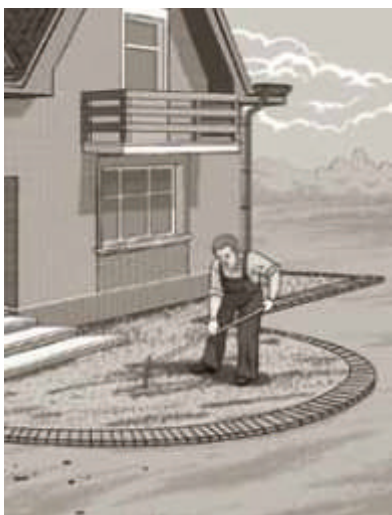
Укладка очередных рядов клинкерной брусчатки.
