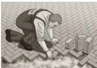
Мощение поверхности с формированием узора «елочка».
